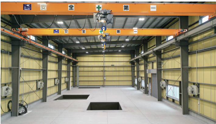
▲内部(プラント設置前)
